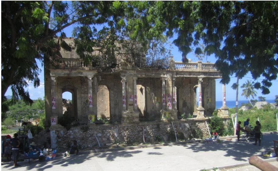
Vestiges de la maison de l'ancien Président Haïtien Sudre Dartiguenave à Anse-à-Veau
