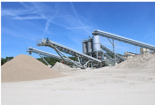
Procédé de criblage des granulats (gravel plant)
