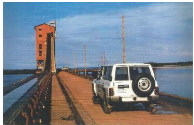
Port minéralier de Miragoâne laissé par la RHM
