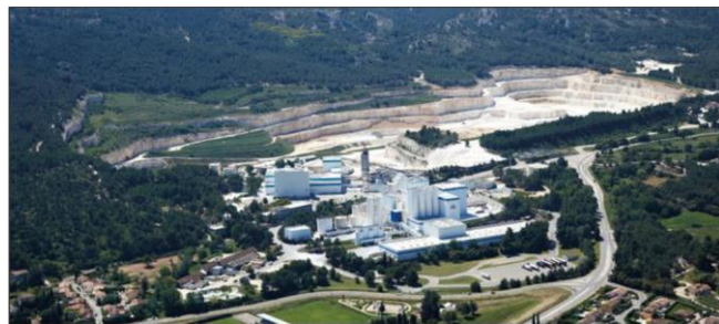
Installation d'une usine de fabrication de GCC à proximité de sa carrière (Source Omya)
