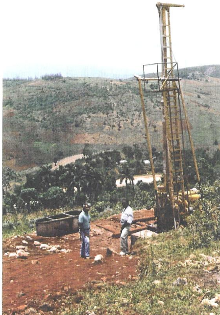
Travaux de sondage exécutés à Pascal-Icart
