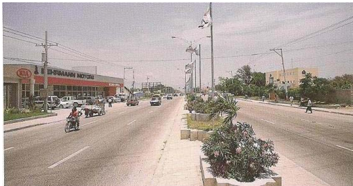
Une vue de la nouvelle route de l'aéroport
